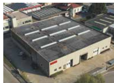
STABILIMENTO D in Località Campagna 53 a Valdagno
