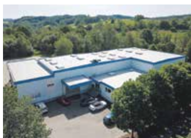
CROCCO DEUTSCHLAND GMBH stabilimento in Germania
